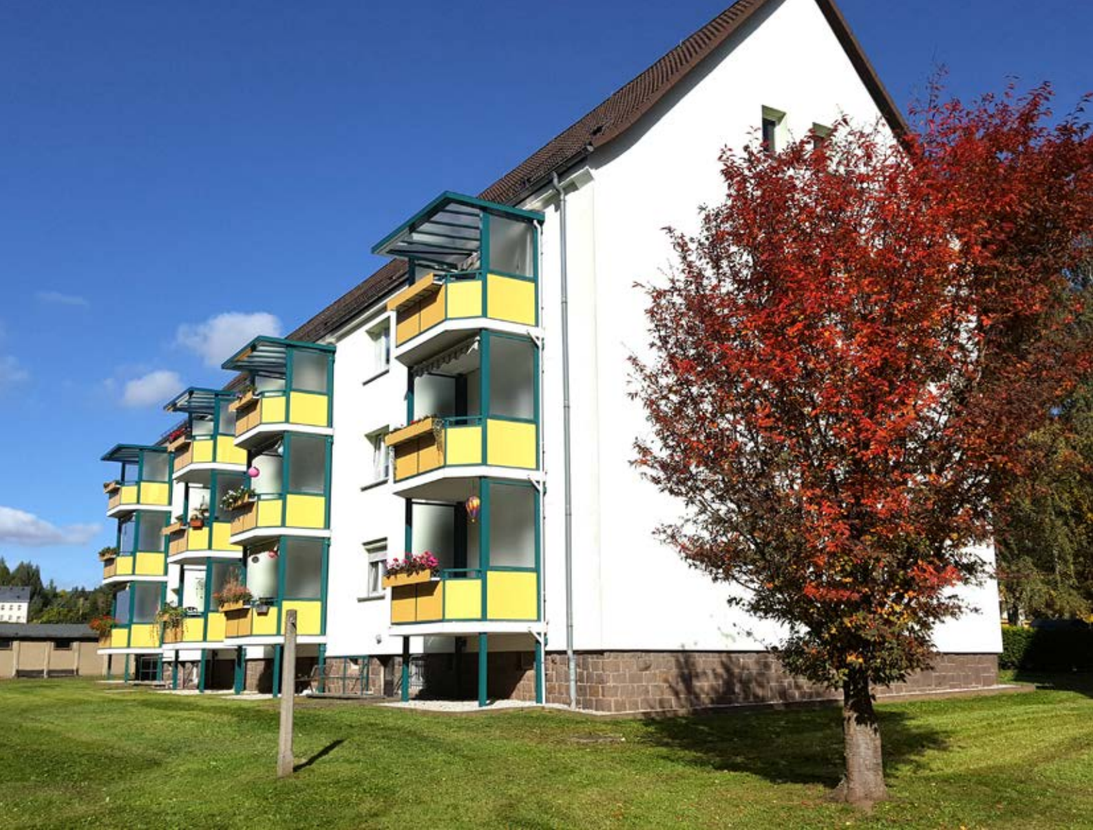
↑ Fertiggestellte Balkone Siedlung des Friedens 12
